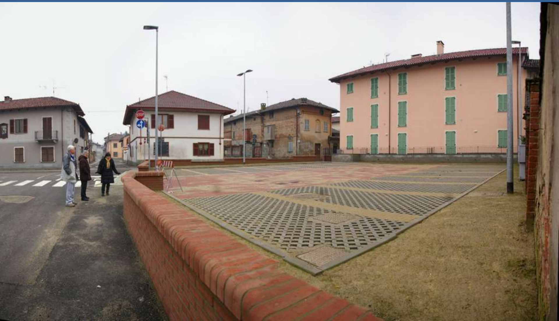
Parcheggio – Casa di riposo (A Villanova d’Asti)
