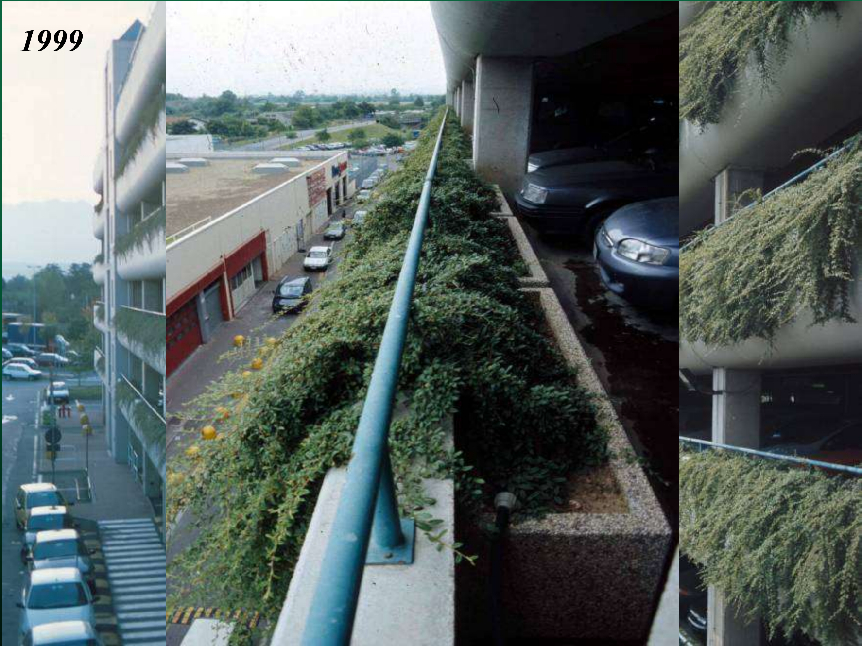
Autosilos Centro commerciale a Grugliasco (TO)
