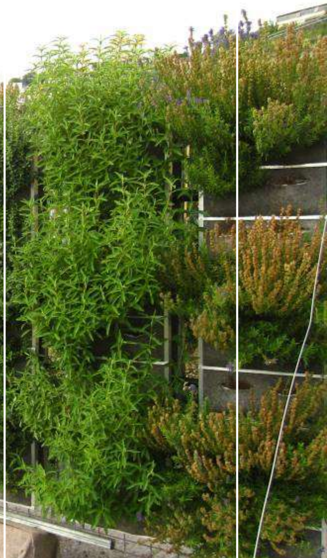
SANREMO, muro sud – ottobre 2010
