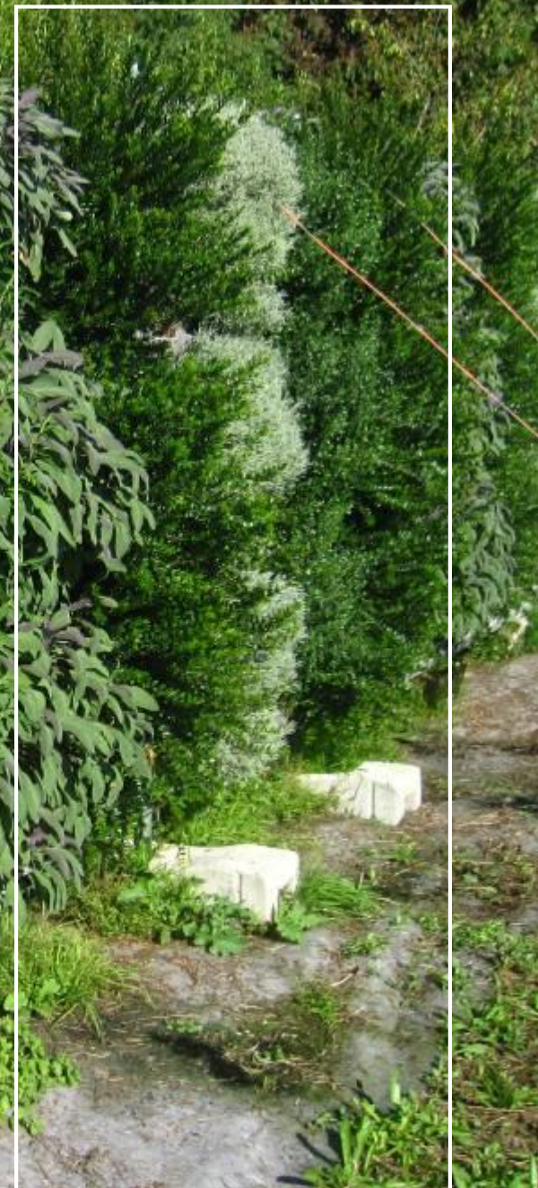
ANTIBES, particolare del muro ovest
