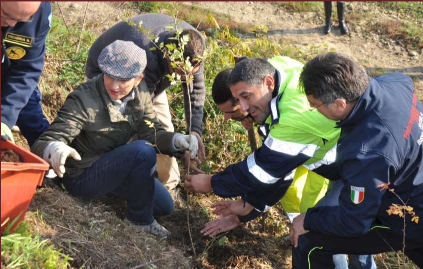
Messa a dimora delle piante per consolidare la scarpata franosa del tratto di strada Sp 8 con lo scavo delle buche da parte del Sindaco di Revigliasco d'Asti, Giuseppe Contorno, e del Sindaco di Mongardino, Barbara Baino, con l'aiuto di personale della Protezione civile ed in particolare del Dott. Roberto Cerrato
