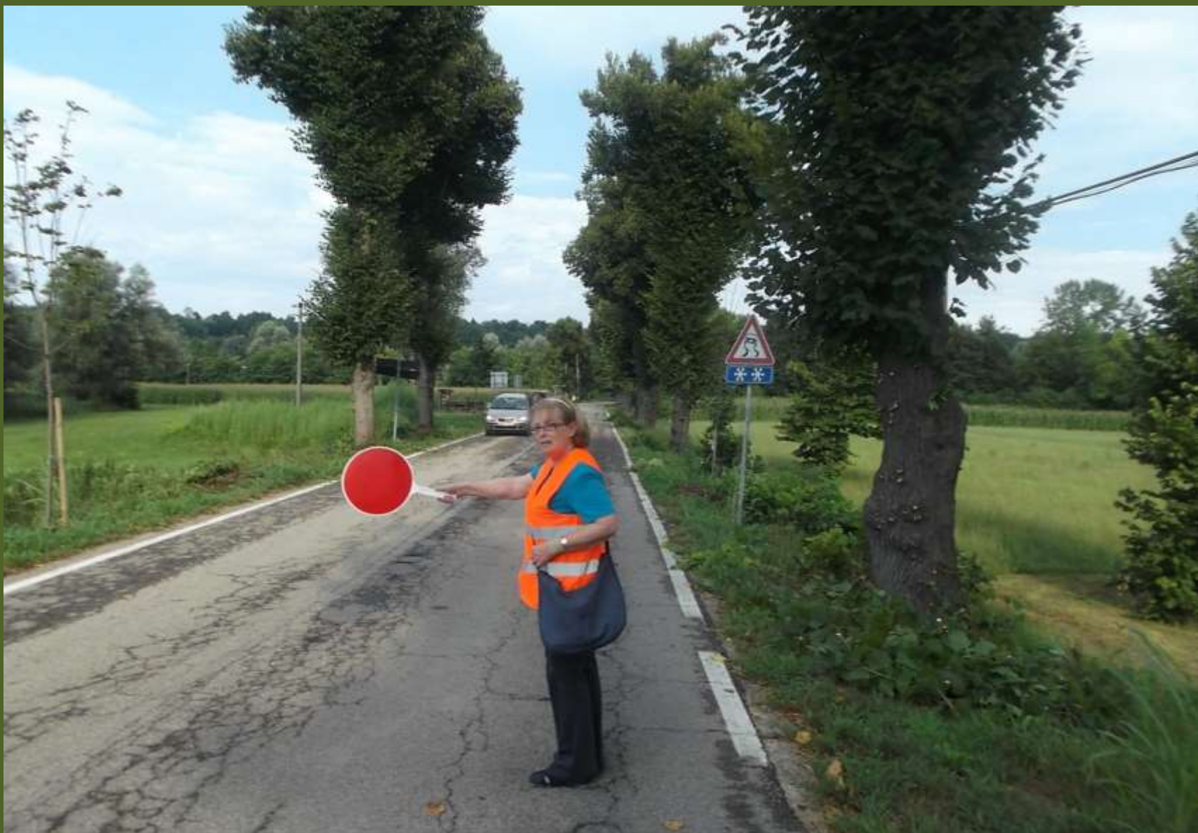
Regolazione del traffico alternato per la gestione in sicurezza del Cantiere stradale di spollonatura
